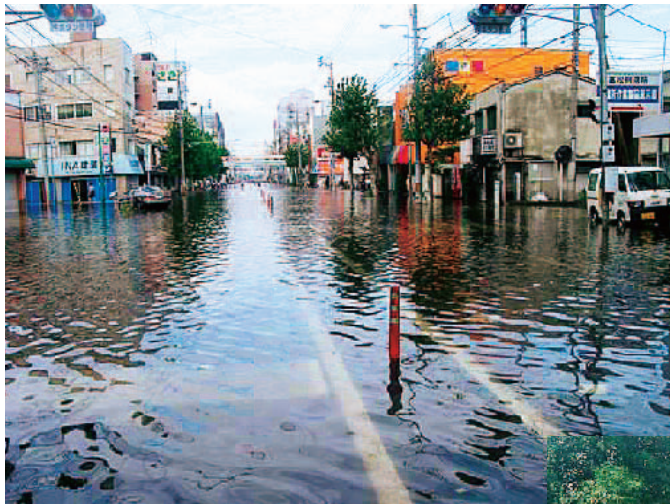
▲高潮で浸水した高松市内 (高松市松島町国道11号)
